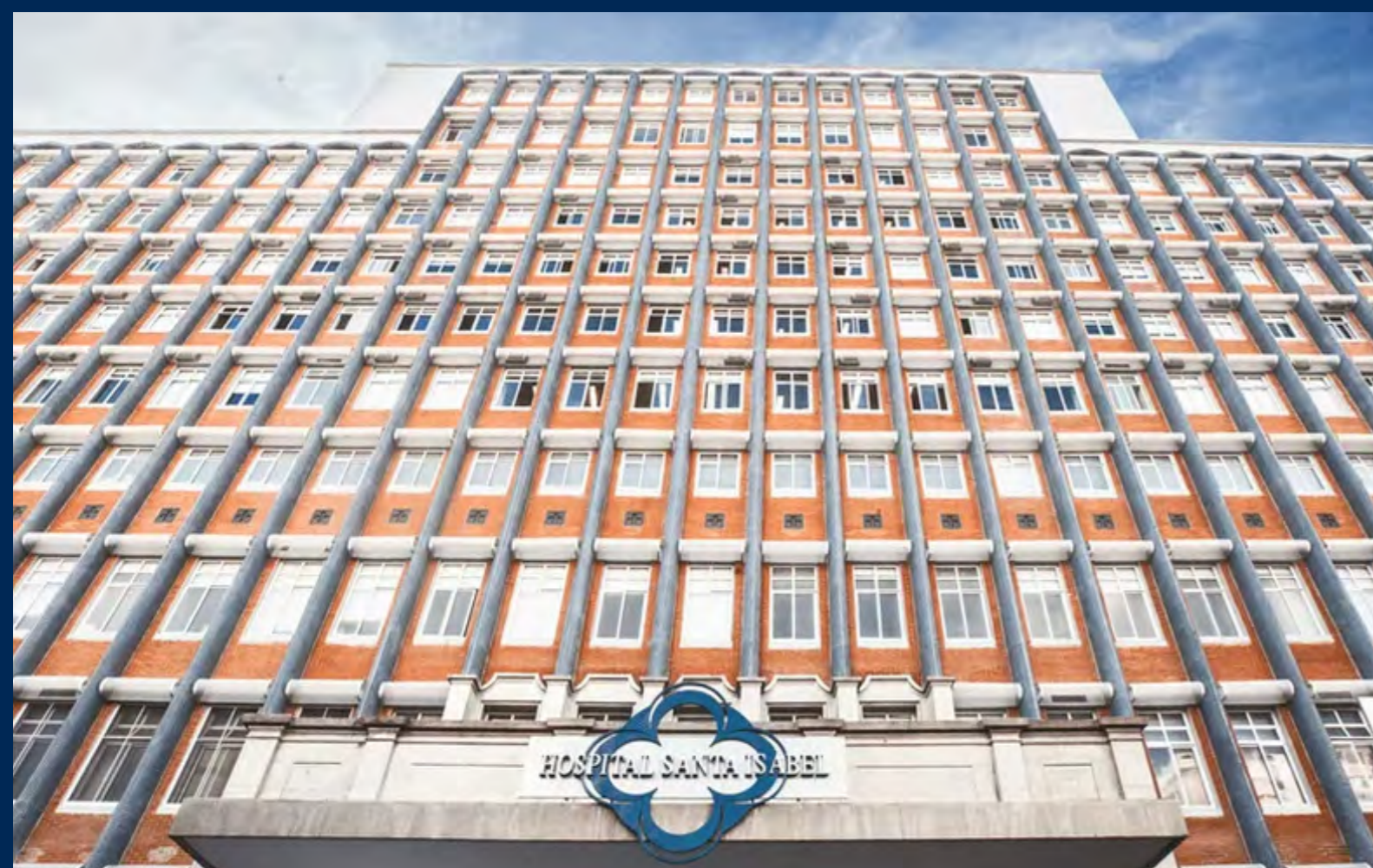
Hospital Santa Isabel, em São Paulo
